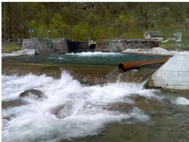
Vista dello sbocco del canale di scarico della centrale ENEL e della nuova traversa di presa dell'impianto in progetto già realizzata nel 2008
